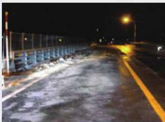
橋梁の手前は乾燥していますが、橋梁上のみ凍結しています。
