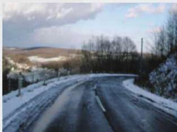
山間部の斜面による日陰部分が凍結部分となっています。
