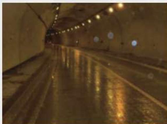
トンネルの手前は乾燥していますが、トンネル内の出入口付近が一部凍結しています。
